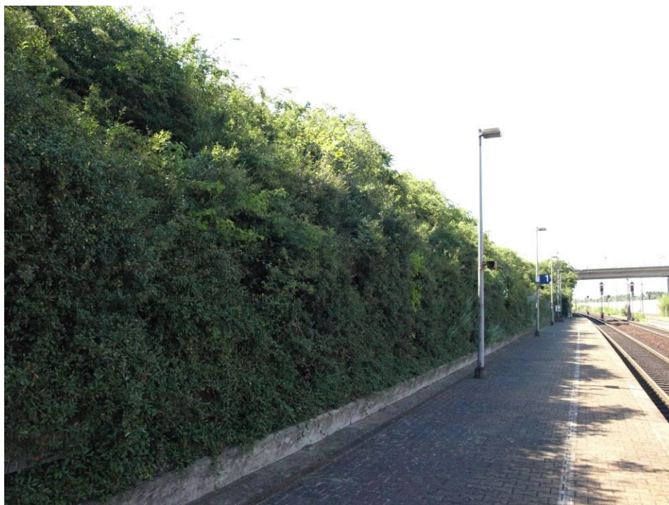
Foto 1 - Raumgitterwand am Bahnsteig Bf. Hockenheim (Abschnitt Raumgitterwand) - Blickrichtung: süd
