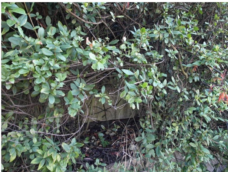
Foto 2 - Detail der Raumgitterwand am Bahnsteig Bf. Hockenheim
