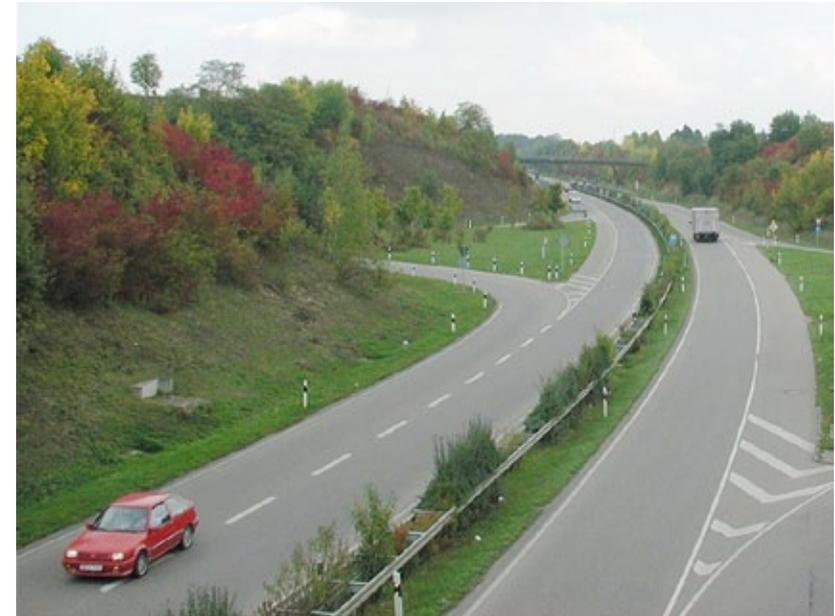
Abb. 7/7 Beispiel eines Lärmschutzwalls (Stuttgart-Weilimdorf, Pfaffenacker, B 295)
